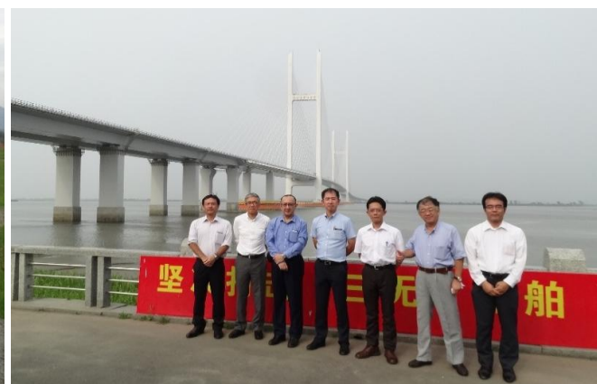
※2017年7月19日 新鴨綠江大橋
